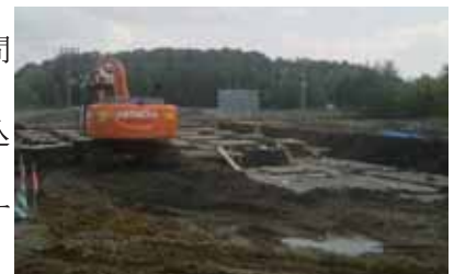
平成31年春のオープンに向け着々と進む工事
