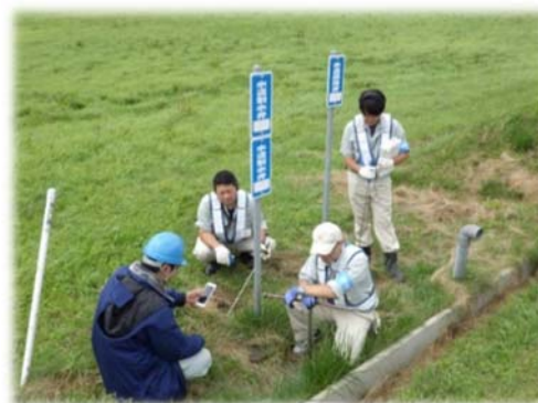
写真 上水道漏水調査
