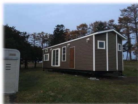
トレーラーハウス
