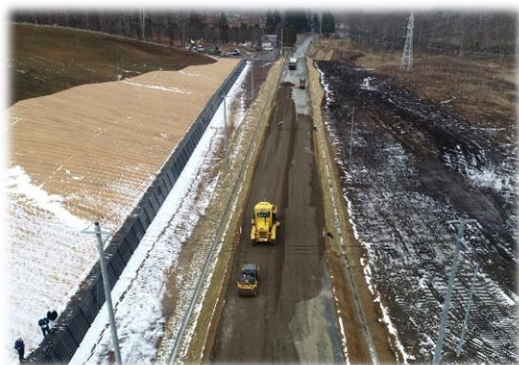
道路復旧工事の状況
