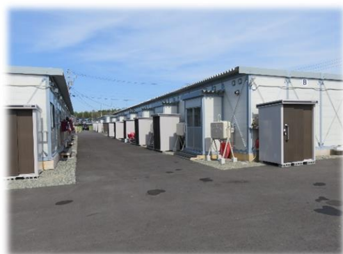
応急仮設住宅
