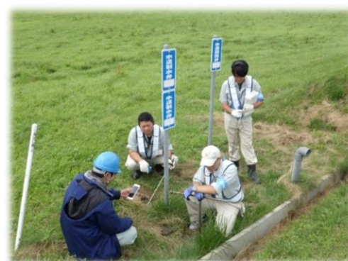
上水道漏水調査
