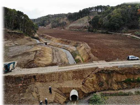
河川復旧工事の状況
