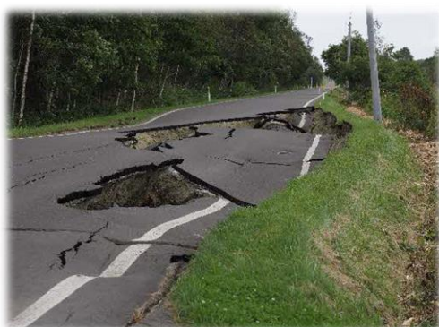
道路の被害状況
