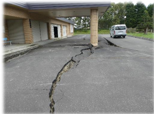
斎場の被害状況
