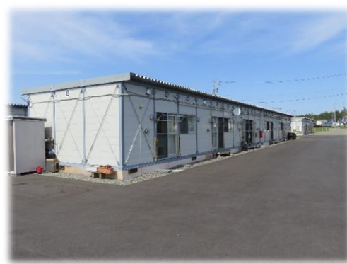
応急仮設住宅
