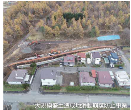
下水道復旧工事の状況
