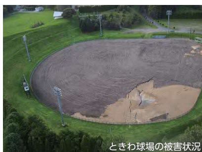
学校の被害状況
