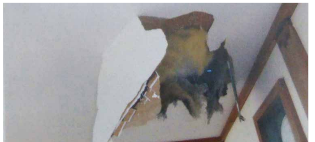
「一部損壊」判定と思われる事例 天井の一部、1箇所穴が開き、空が見える状態となったもの。(住宅内部の写真)
