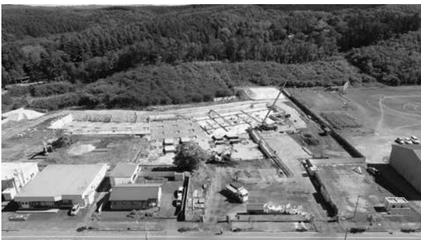
写真4 9月14日の建設現場の様子
