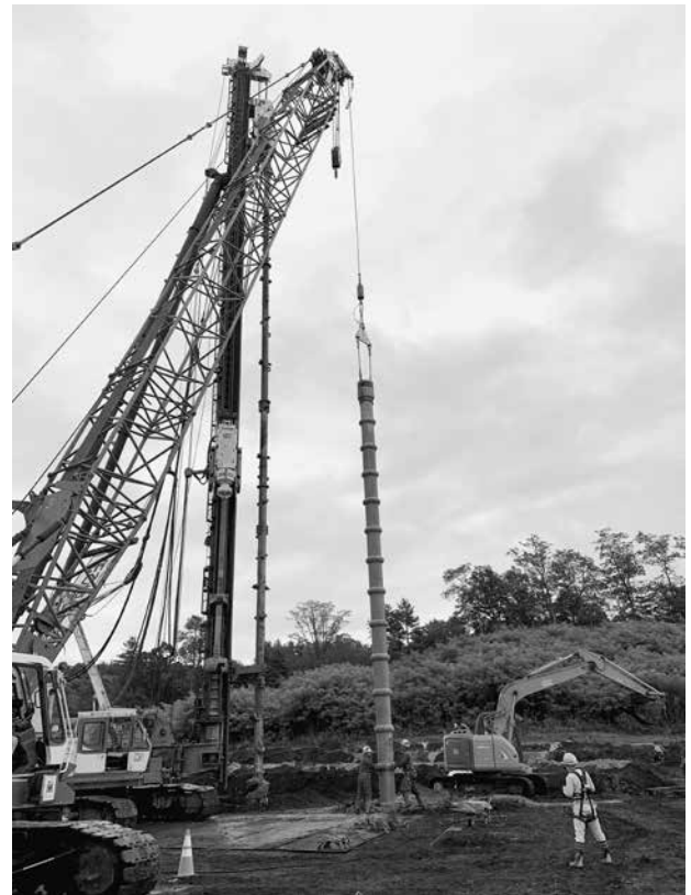
写真2 8月26日の杭工事の様子
