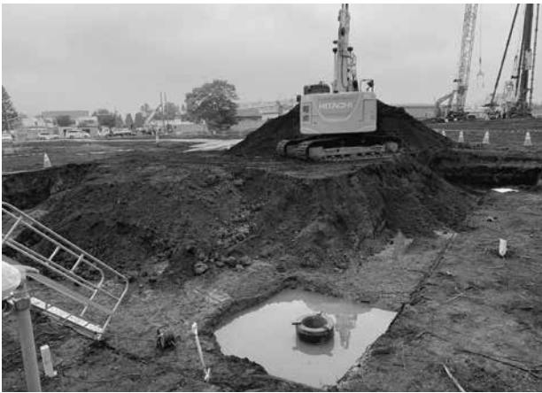
写真1 8月24日の掘削作業の様子
