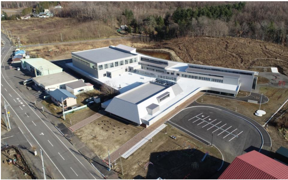
完成した安平町立早来学園校舎
