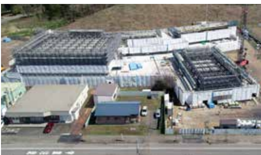
令和4（2022）年5月10日現在の工事の様子 （間もなく屋根の工事が始まります）
