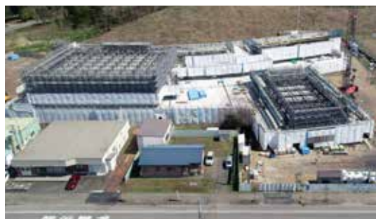
令和4（2022）年5月10日現在の 工事の様子 （間もなく屋根の工事が始まります）
