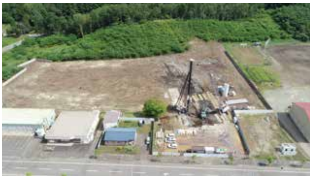
写真3 8月12日の建設現場の様子
