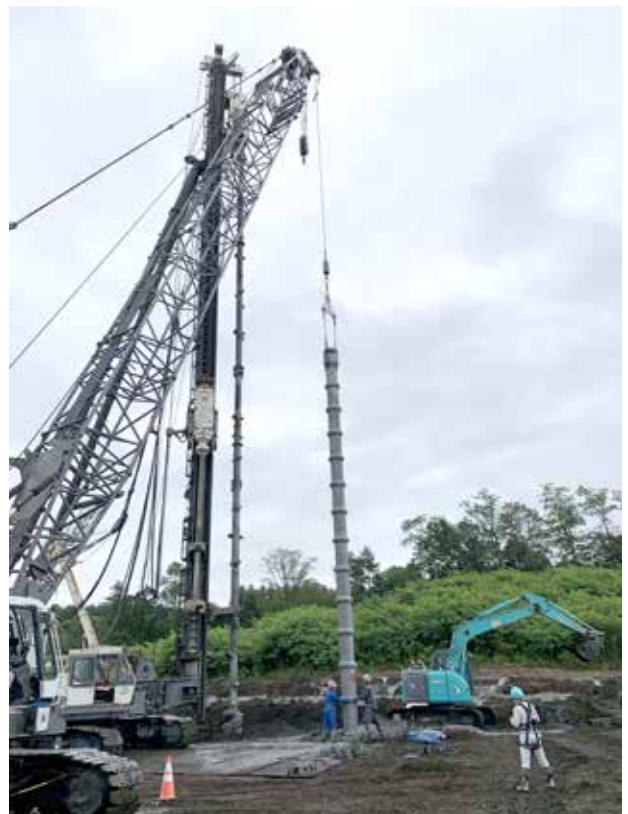
写真2 8月26日の杭工事の様子
