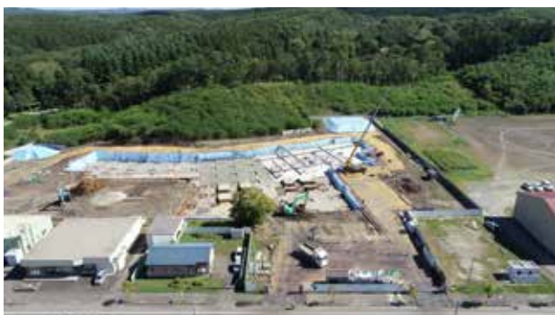
写真4 9月14日の建設現場の様子
