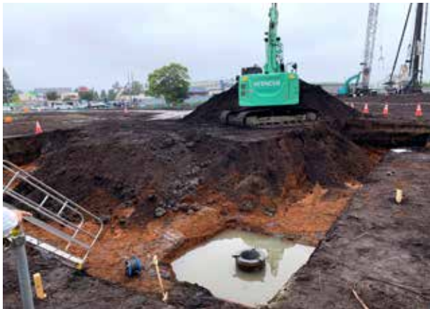
写真1 8月24日の掘削作業の様子
