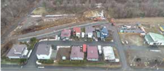
早来北進地区 (施工中)
