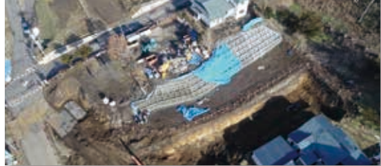
追分柏が丘地区 (施工中)
