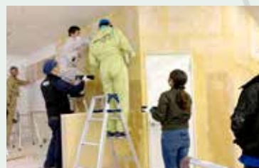
改修作業時の様子
