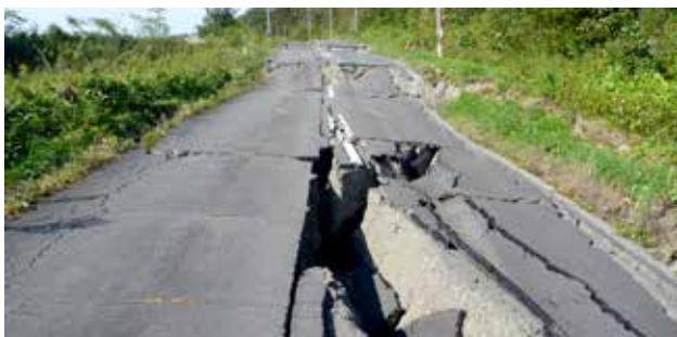
被災直後の守田開拓線 路面に大きな亀裂が走った
