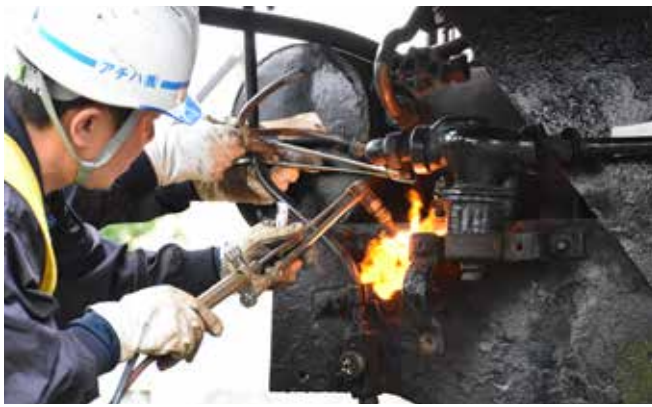
①6月13日。現場が慌ただしくなってきた。時折、バーナーなどを使いながら吊り上げ作業の準備を進めて行く。
