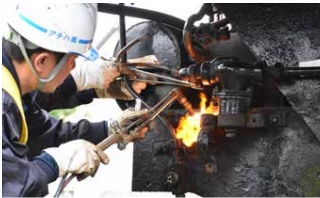
①6月13日。現場が慌ただしくなってきた。時折、バーナーなどを使いながら吊り上げ作業の準備を進めて行く。
