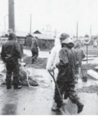
土のう積みで市街地への濁流を防ぐ
