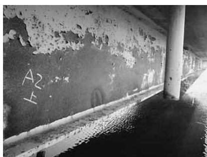
↑ 鋼橋の塗装面の腐食
