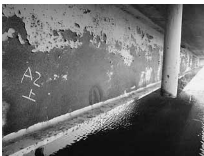
↑ 鋼橋の塗装面の腐食
