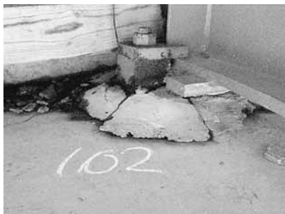
↑ 支承のモルタル欠損
