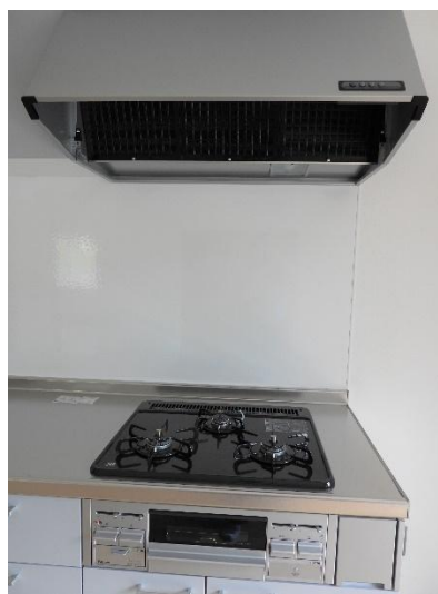
ガスコンロとレンジフード
