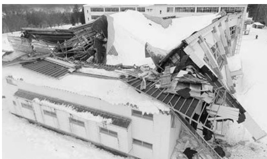
崩落した早来中学校体育館の屋根
