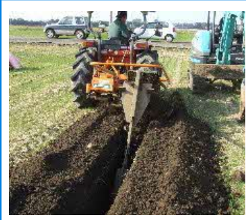
暗渠排水の整備
