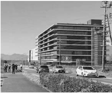
建設中の半導体工場
